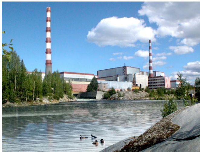
Kola kjernekraftverk ved Polyarni Zori i Russland (Foto: Kola kjernekraftverk)
