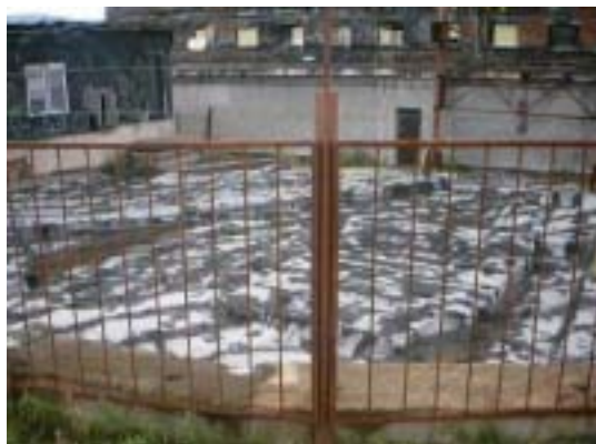
Lagertank med brukt brensel
