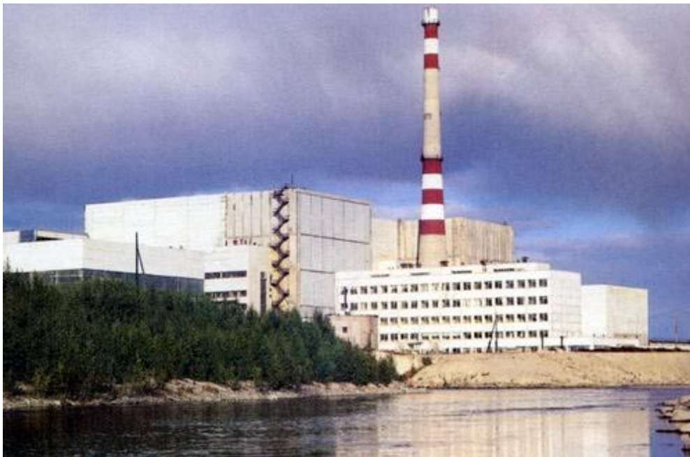
Kola kjernekraftverk (Foto: Statens strålevern)
