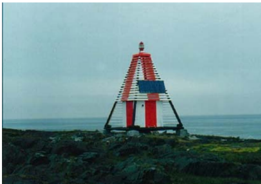
Russisk fyrlykt på Kola-halvøya med nylig installert solcellepanel. Foto: Fylkesmannen i Finnmark
