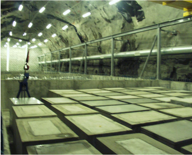
Deponering av kasser i den innerste seksjonen i hall 4.
