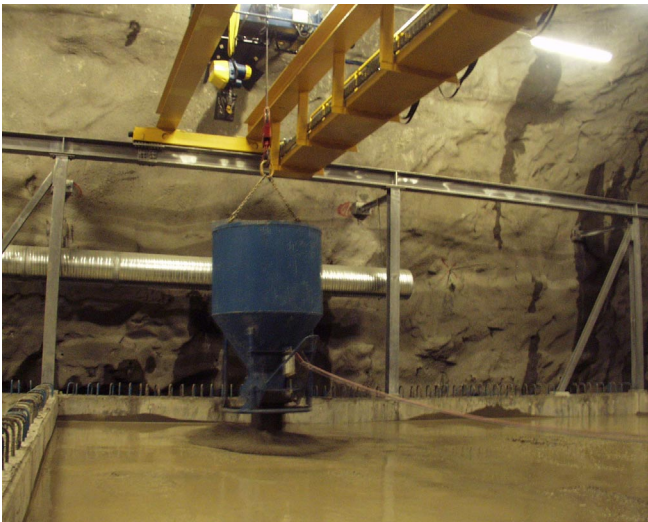
Innstøping av avfallsbeholdere i seksjon 4 i hall 4.
