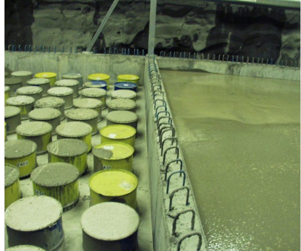
Innstøping av tønner og kasser i seksjon 3 og 4 i hall 4.
