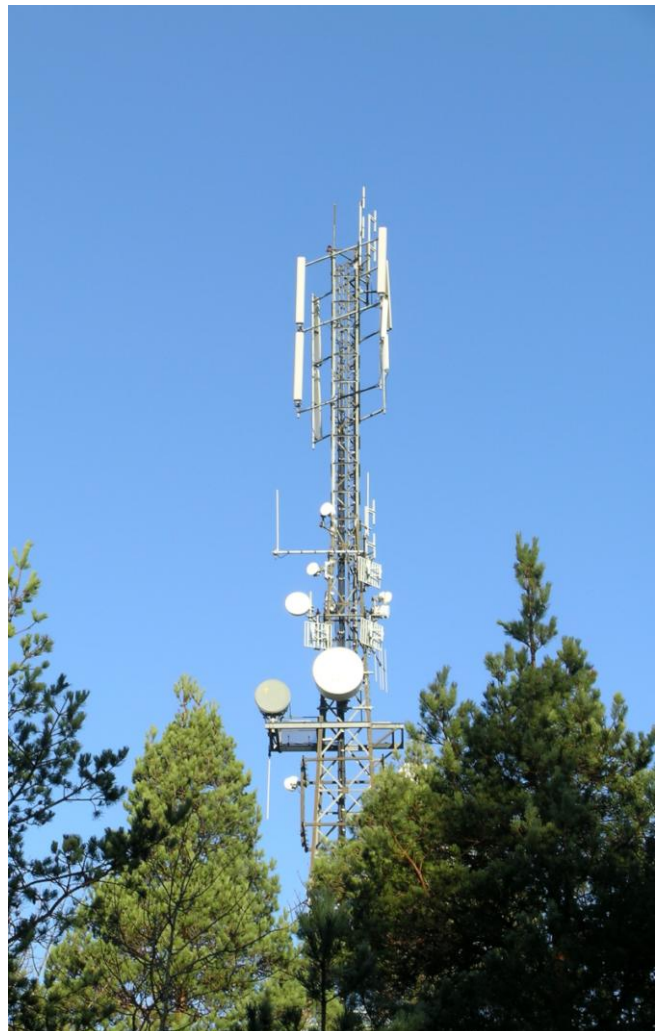
Antennene til det nye nødnett plasseres som regel høyt over bakken i master ofte sammen med mobilantenner og andre sendere. (Foto: Dag A. Fedøy, Strålevernet)
