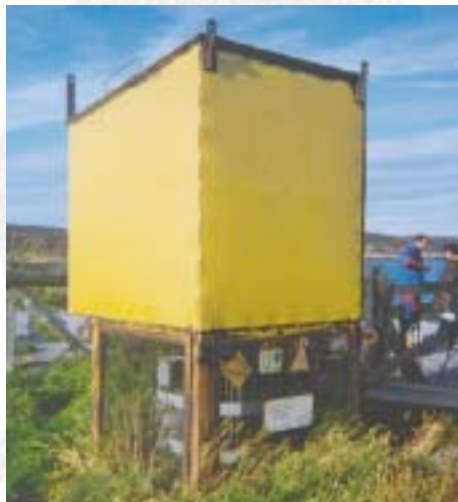
РИТЭГ с защитой и источником питания. Фотография: Норвежское агентство по радиационной защите
