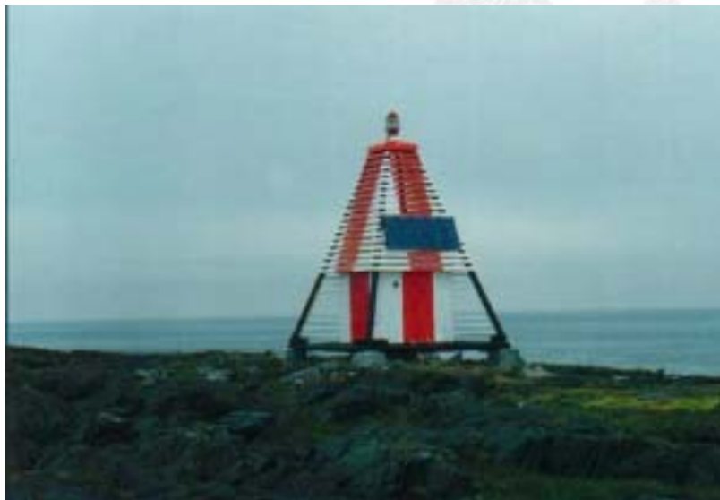
Альтернатива к РИТЭГу: маяк с солнечными батареями, производящими электричество. Фотография: Офис губернатора
