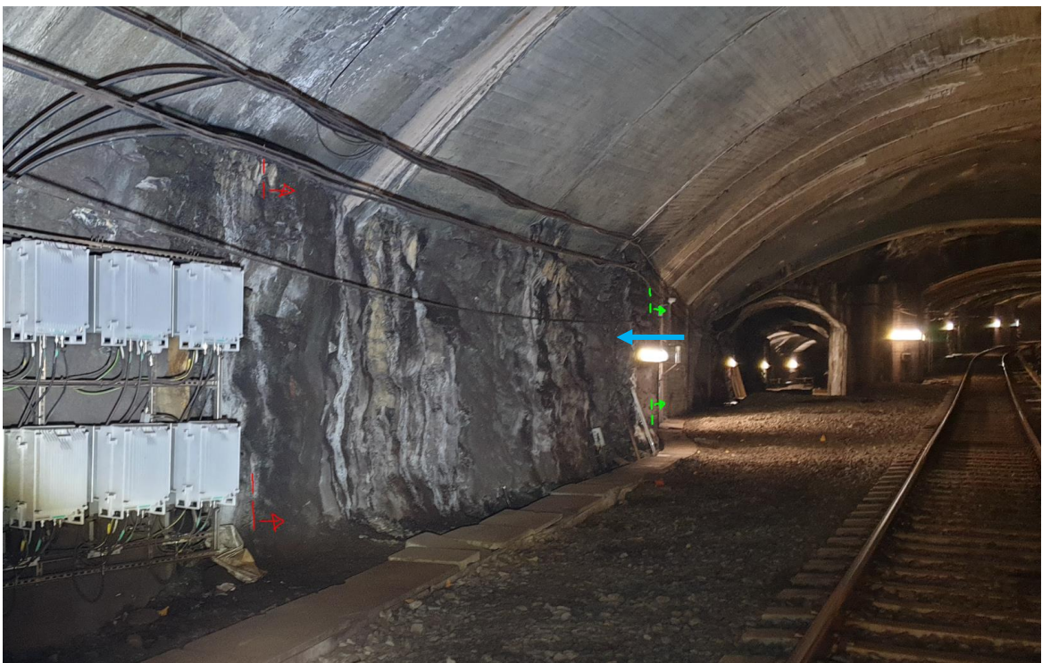
Bilde 6: Bildet viser tunnelveggen hvor den nye sjakten kommer ned. Pilen viser omtrentlig hvor sjakten vil være nærmest tunnelen. Grønn markering viser hvor det er betongstøp helt ned til såle bort til tverrforbindelsen. Røde piler viser hvor det vurderer behov for supplerende bergsikring mot betongstøpen.
