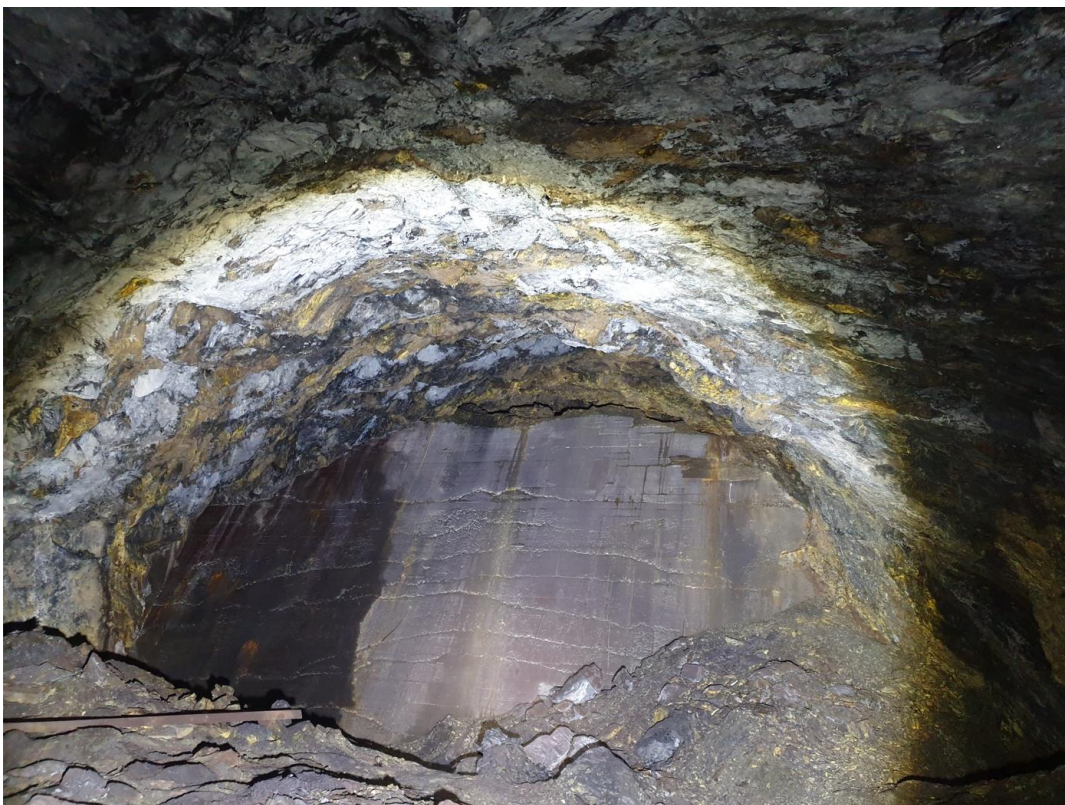
Bilde 14: Bilde viser Heibergløkka tverrslag sett mot plattform 4. Tverrslaget er støpt igjen med en betongvegg mot plattformen. Større utfall på såle i høyre bildekant.
