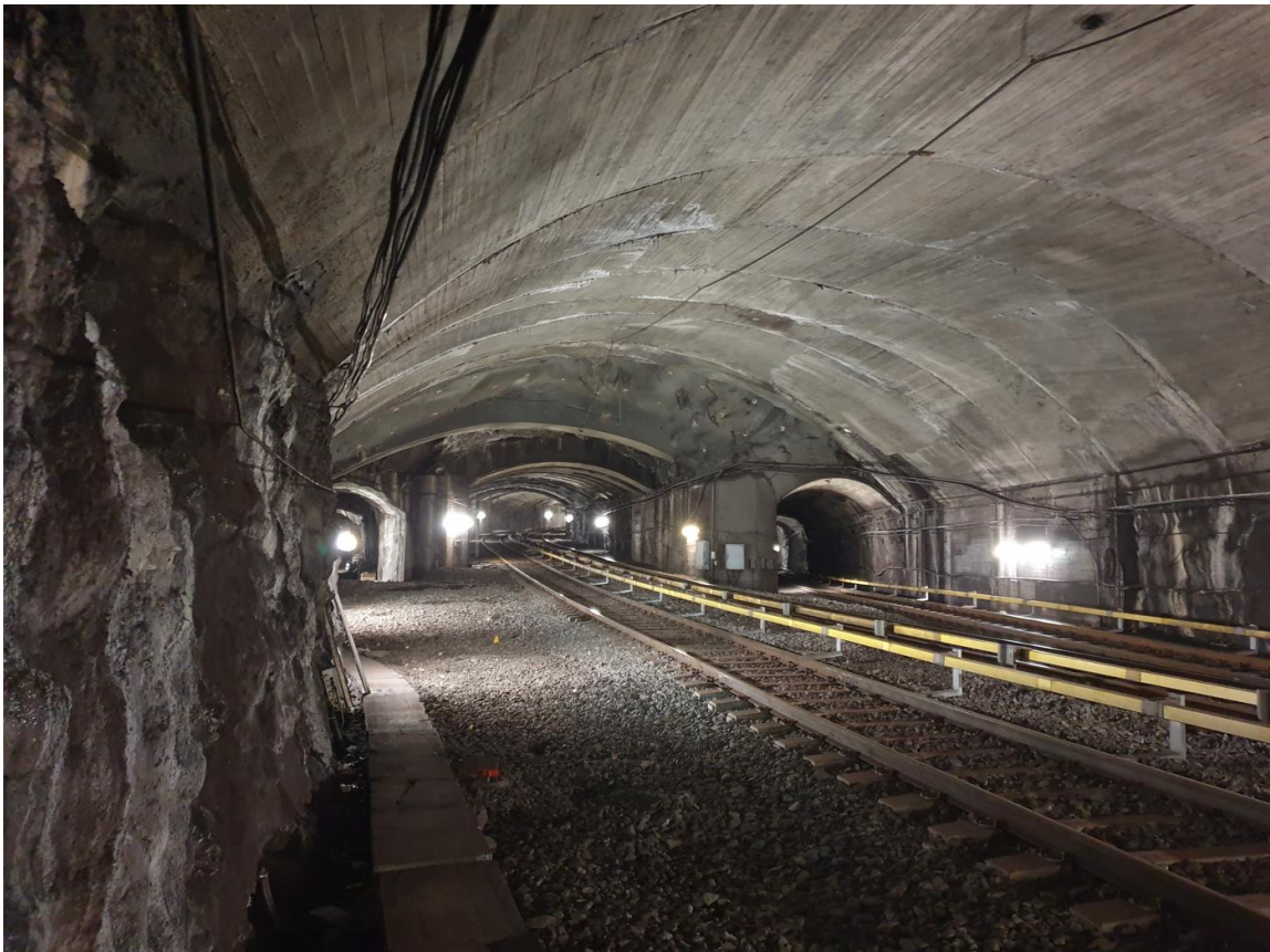
Bilde 7: Betonghvelv i området rett sørvest for hvor ny sjakt vil være nærmest T-banetunnelen med spor 1 og 2. Betonghvelvet er støpt ned til vederlag, enkelte steder er det støpt helt ned til sålen.
