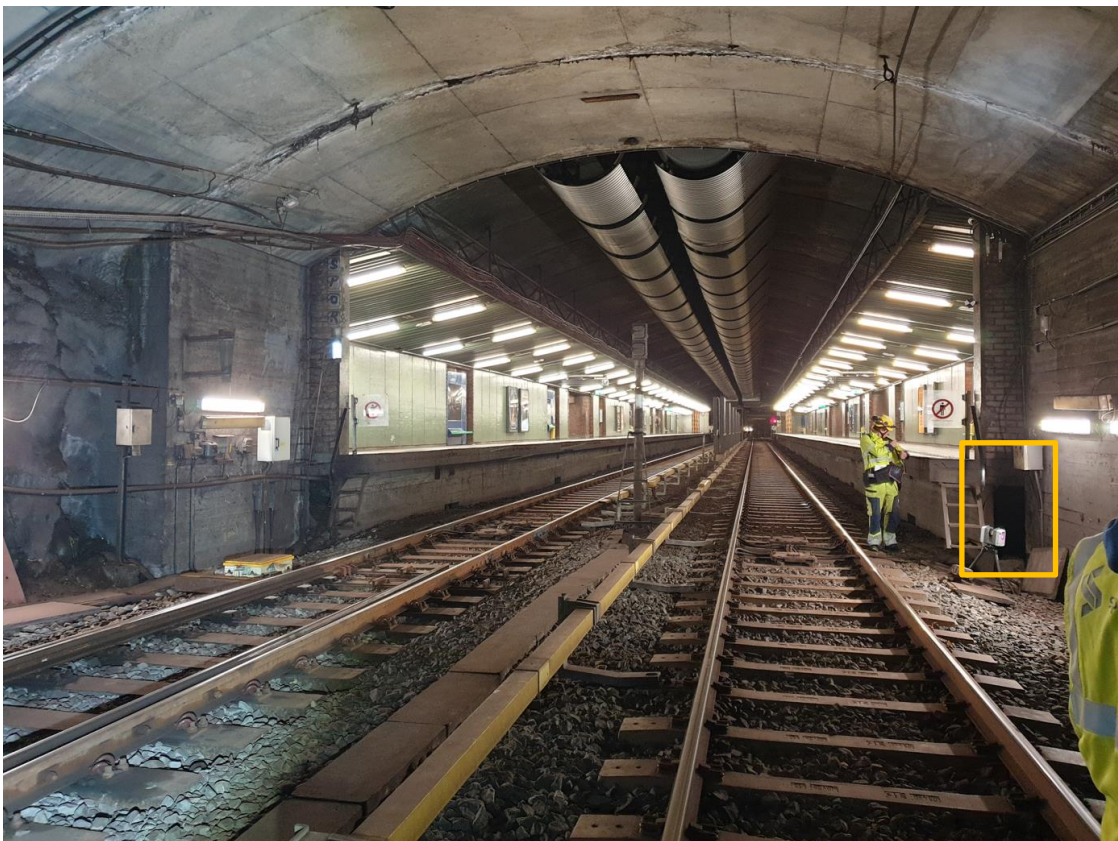
Bilde 3: Bilde viser T-banestasjonen med spor 1 og 2, sett i retning sørvest/sentrum. Gult omriss viser dagens adkomst til Heibergløkka tverrslag under plattform 2.
