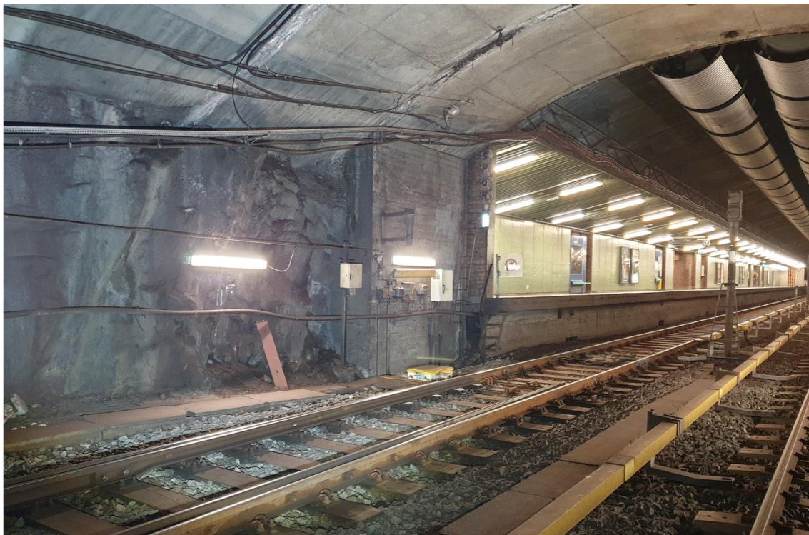
Bilde 8: Bildet viser start på betonghvelvet i tunnelen videre nordover fra stasjonen langs plattform og spor 1. Betongstøpen er støpt helt ned til sålen ~1,5-2 meter før betongstøpen videre er avsluttet i vederlaget.
