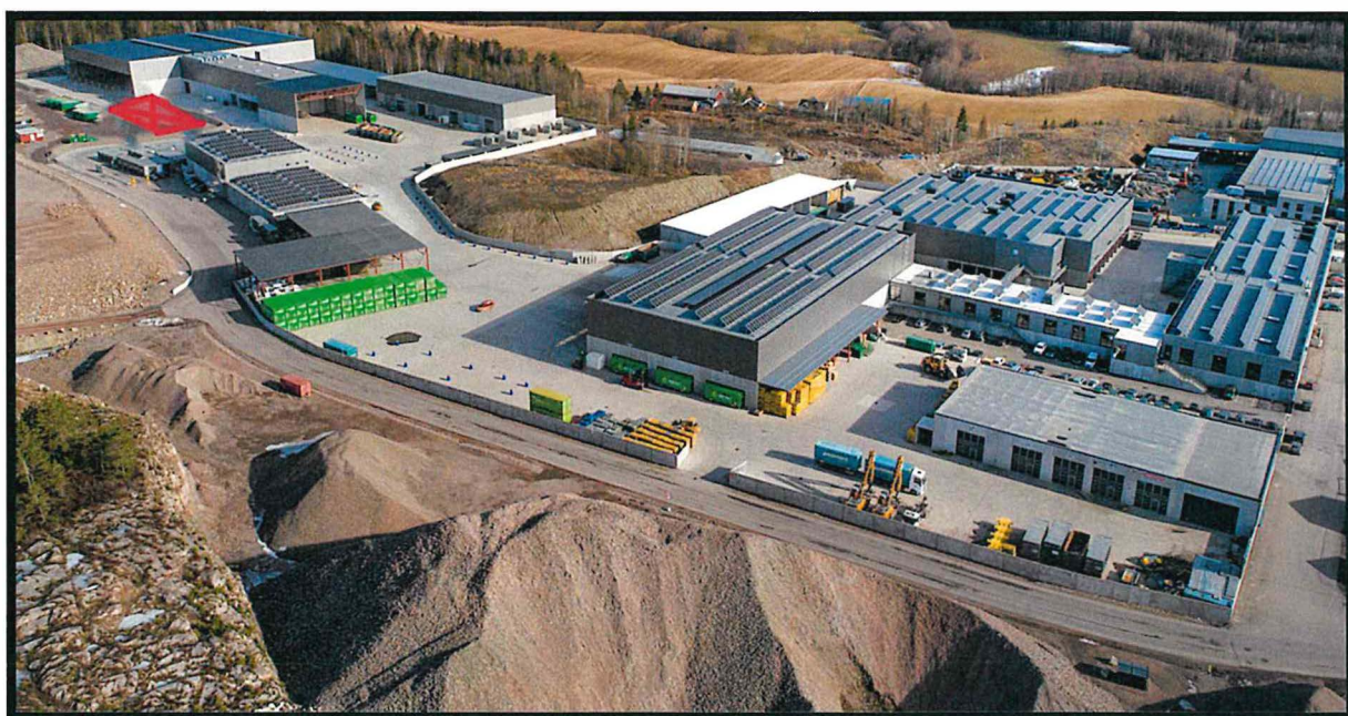
Oversiktsbilde av Revac sitt behandlingsanlegg, nytt lagerbygg merket med rødt
