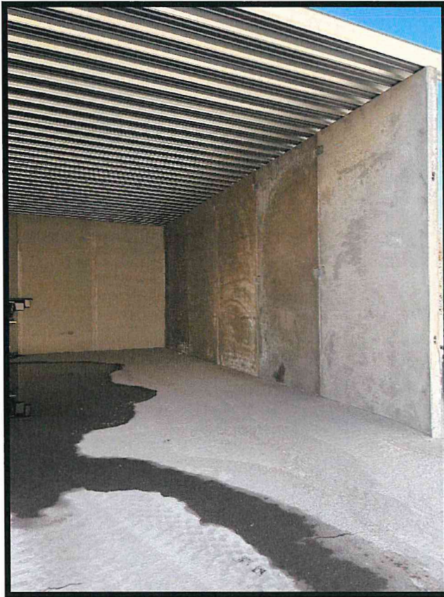
Bilde av aktuell bunker til lagring
