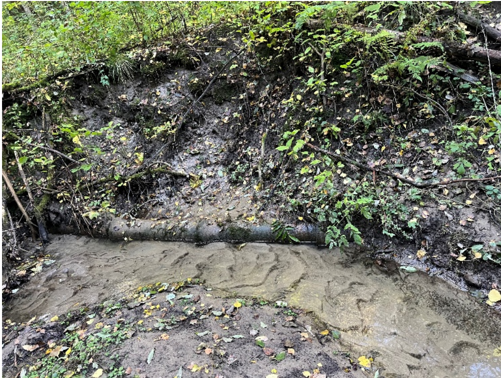
Figur 61 Erosjonskant i Søvittbekken og et rør som stikker ut. (Ecofact)
