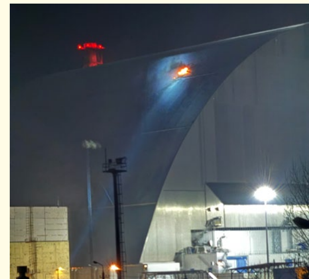
Brann i overbygningen som beskytter kjernkraftverket i Tsjornobyl. Foto: IAEA
